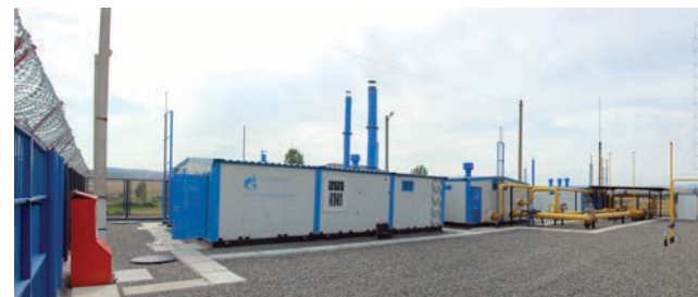
АГРС «Урожай-30» производительностью 30 000 \text{м}^3/\text{ч}
