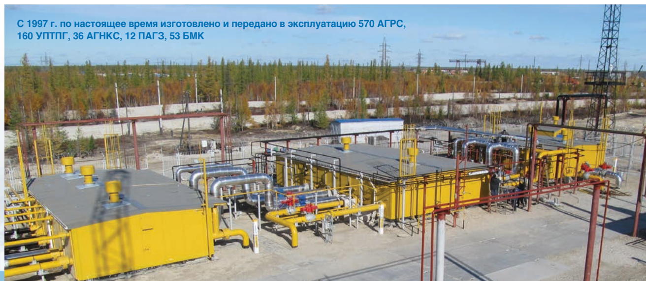
АГРС «Урожай 144» производительностью 144 000 \text{м}^3/\text{ч}
